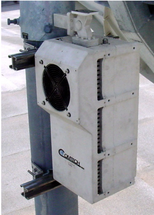
Figure 2-7. Install CSAT 50 Watt Unit
