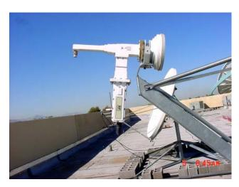
Figure B-8. Installation of LNA
